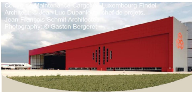
Bâtiments à hautes performances
