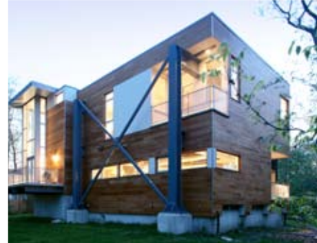
'Big Dig House' te Boston (US), gebouwd met een gerecupereerde staalstructuur van een snelwegviaduct. 'Big Dig House' à Boston (US), bâti avec une structure d'acier récupérée d'un viaduc routier.
