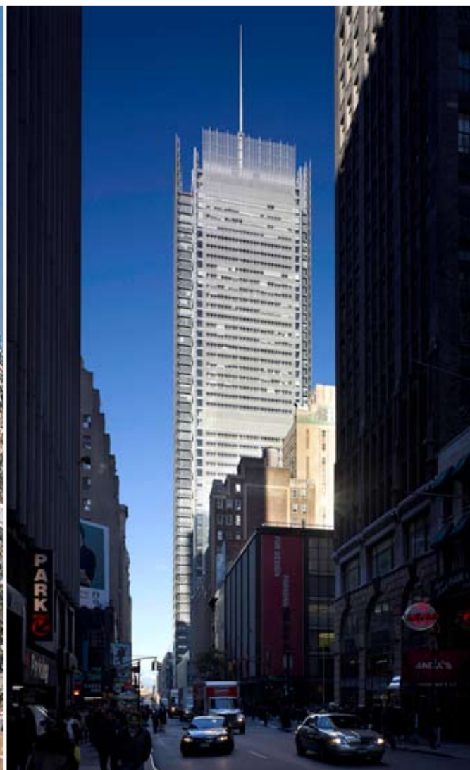
Meer dan 95% gerecycled staal werd gebruikt voor de geheel zichtbare staalstructuur bij de New York Times Building, ontworpen door Renzo Piano (zie ook info_steel 15) _Plus de 95% d'acier recycl  est utilis  dans la structure m tallique enti rement apparente du New York Times Building con u par Renzo Piano (info_steel 15)
